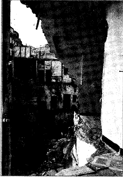
الشكل ٦ تداعي المباني المتلاصقة جملة بسبب تماسكها (مؤسسة رياض الفتاح - الجزائر)
